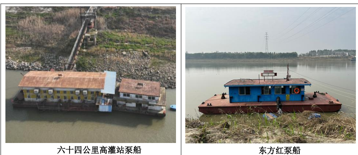
图 3.1-1 取水泵船现状图
