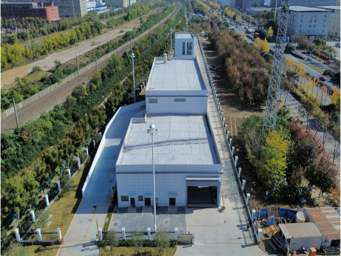
项目实景照片
