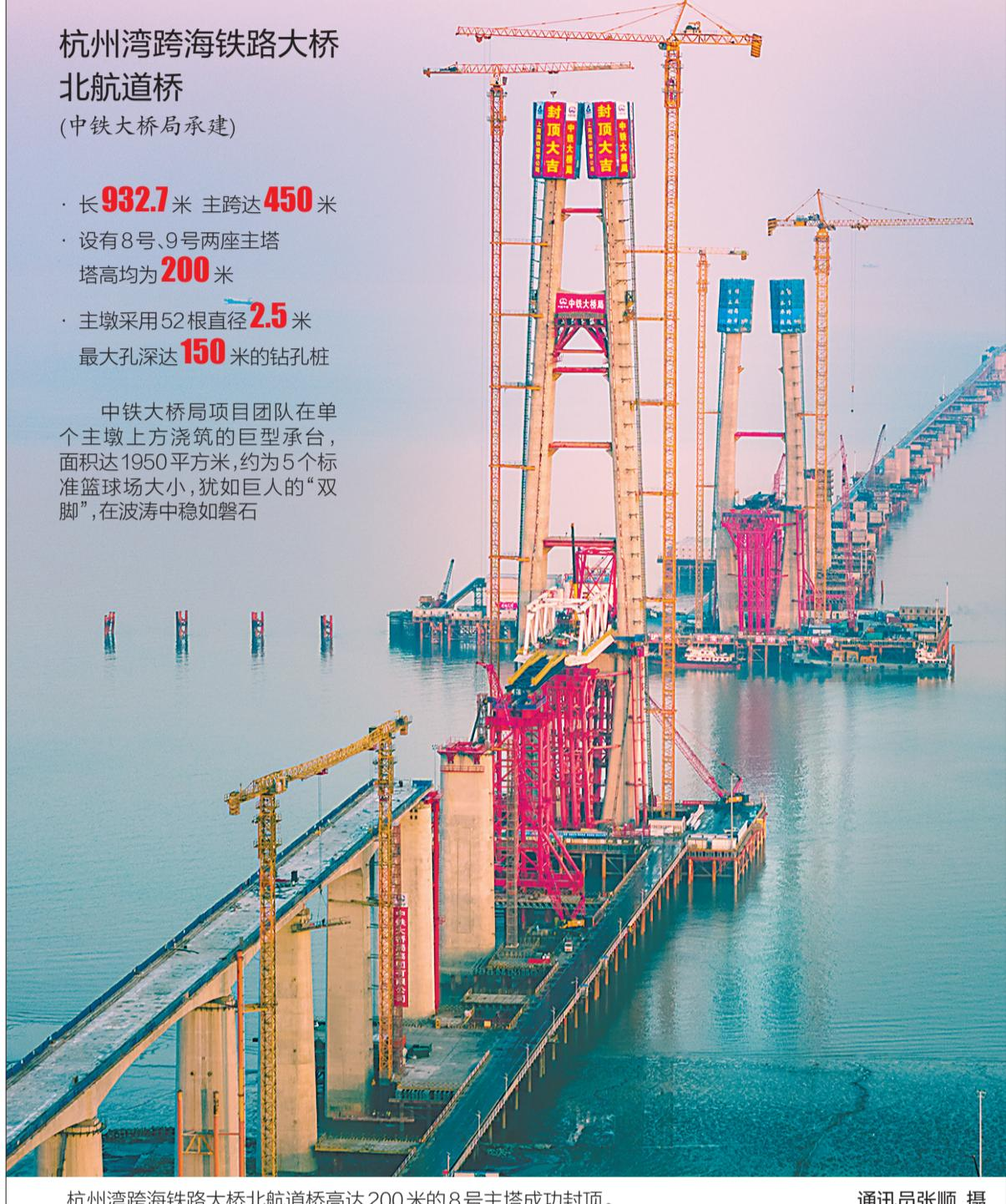
杭州湾跨海铁路大桥北航道桥高达200米的8号主塔成功封顶。 通讯员张顺 摄
