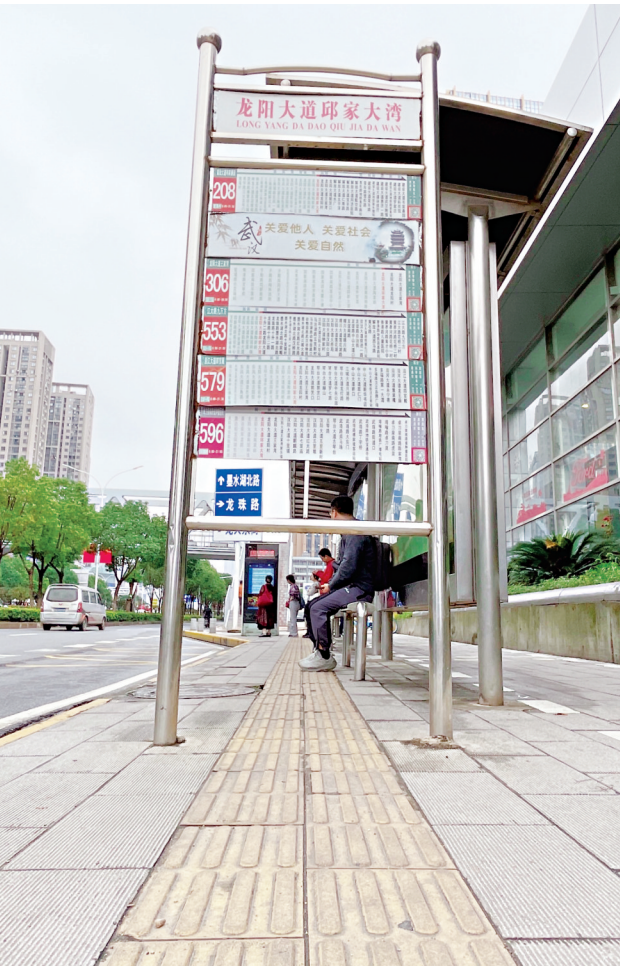
公交站牌竖在盲道上。
