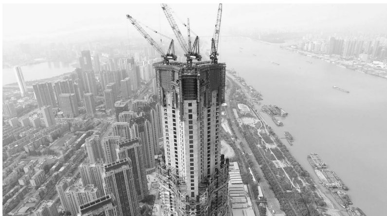
“空中造楼机”施工中
