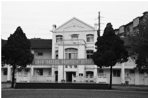
泗湾天主堂旧址主楼，现为弘桥小学教学楼（韩少斌供图）
