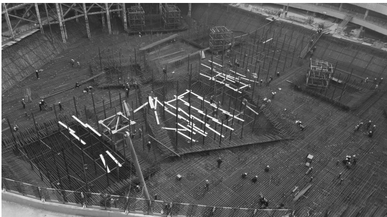
施工现场俯瞰图
