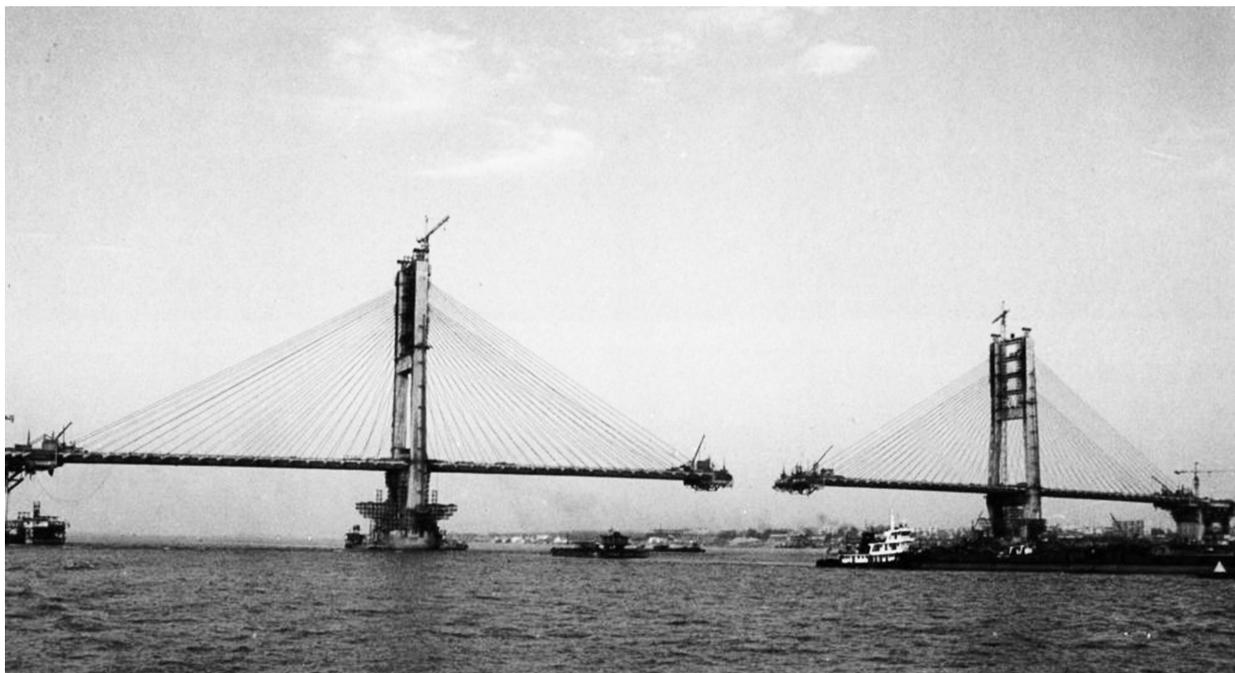
先河。抗高温大吨位冷铸锚头新的填料配方的研制和新的施工工艺的采用，成功解决了斜拉索抗高温的问题，是国内首创。斜拉桥施工中应力、索力测量和跟踪监控，使主梁合龙误差、桥轴线偏差、桥面线形偏差、索力误差均达到了很高的精度。
