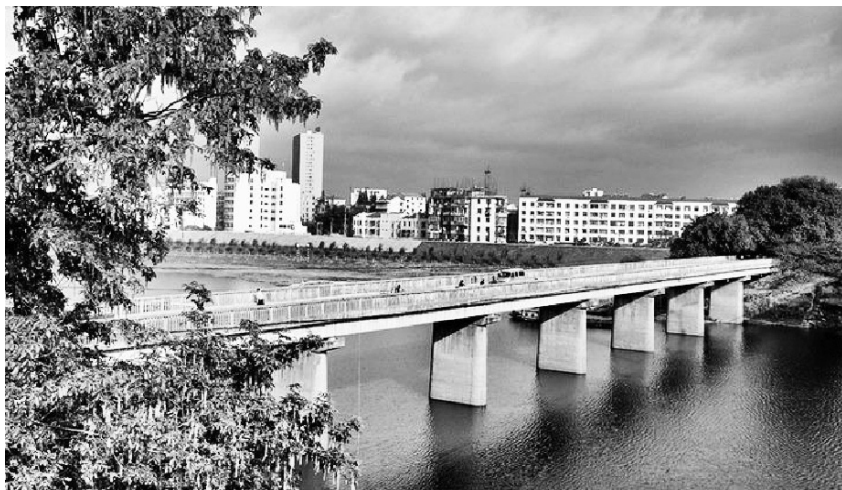
周恩来总理动议建设的黄陂大桥
