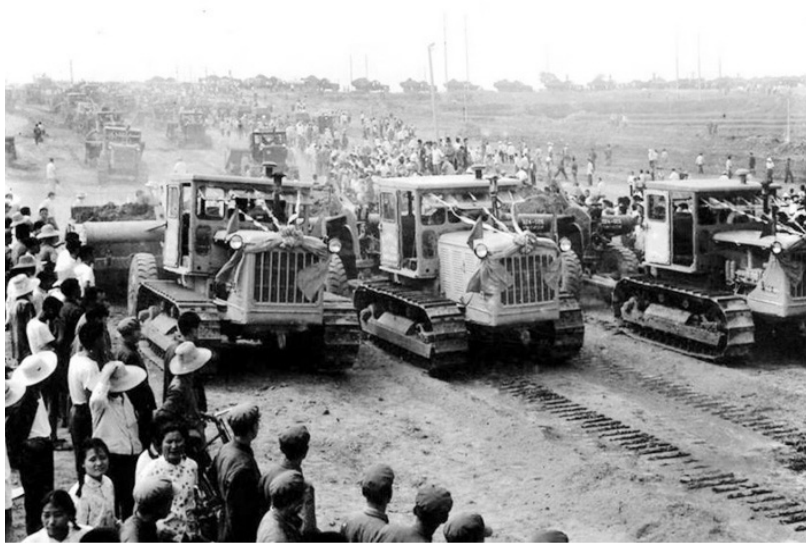
“一米七”工程开工平整场地
