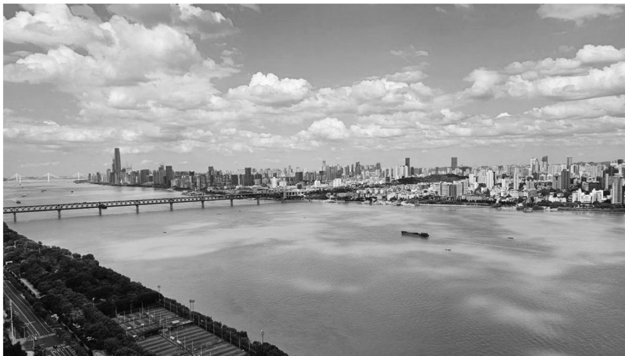
武汉长江大桥、长江二桥依次在江面上排列
