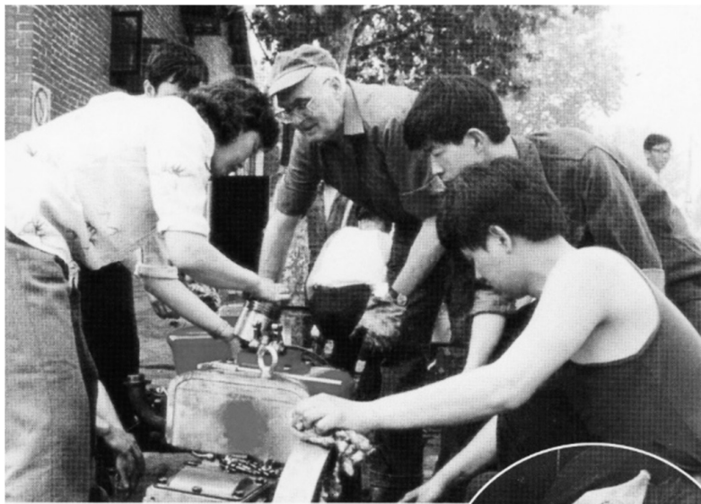
1984年10月，在试车房外柴油机成品停放处，格里希和胡纯梅（左一）分析试车时燃油耗过高的原因
