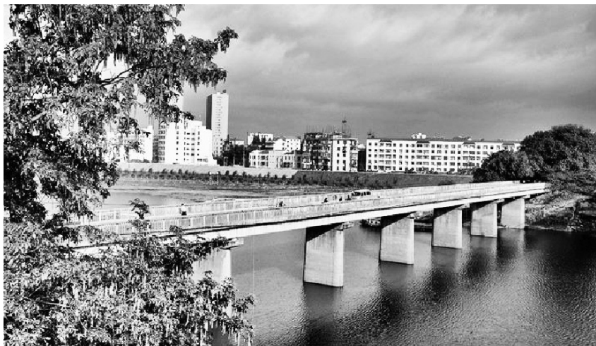
周恩来总理动议建设的黄陂大桥
