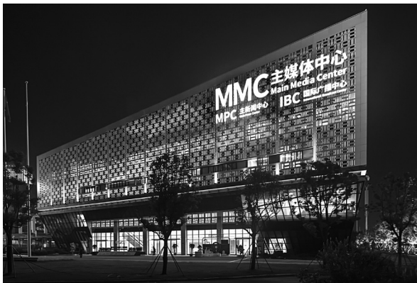
2019年1月武汉第七届军人运动会主媒体中心场馆景观提升项目
