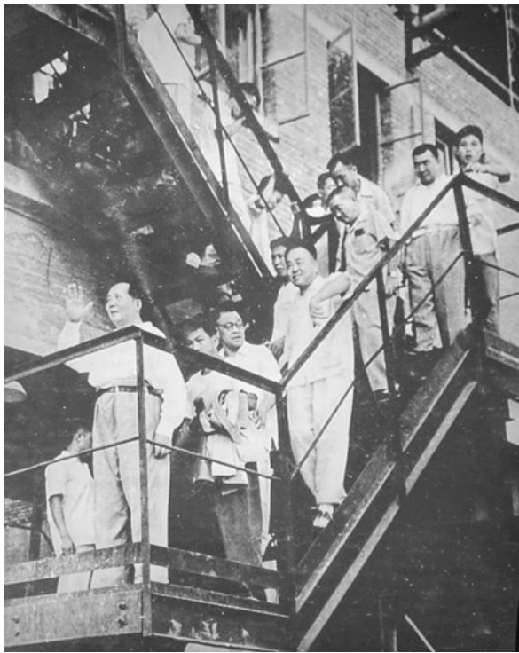
毛泽东在一号高炉铁梯上下
