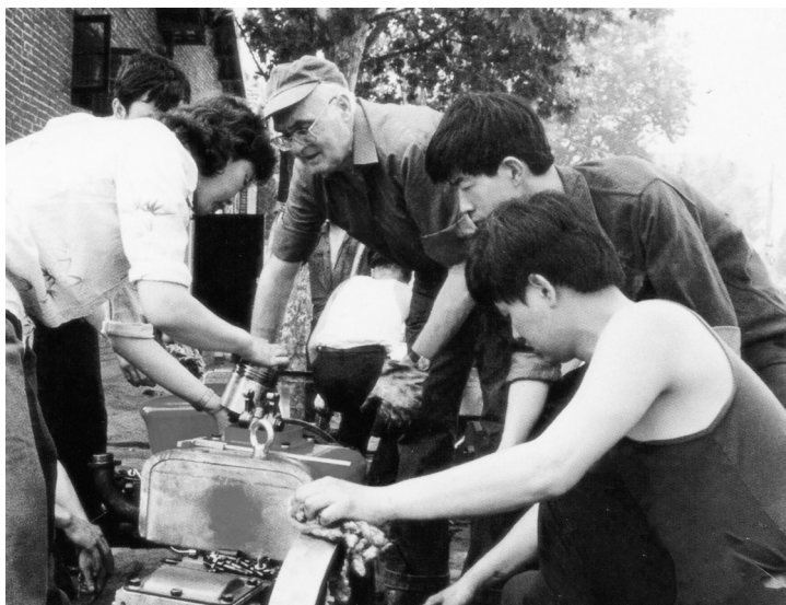
1984年10月，格里希同大家一起拆解试车后的柴油机，分析质量状况
